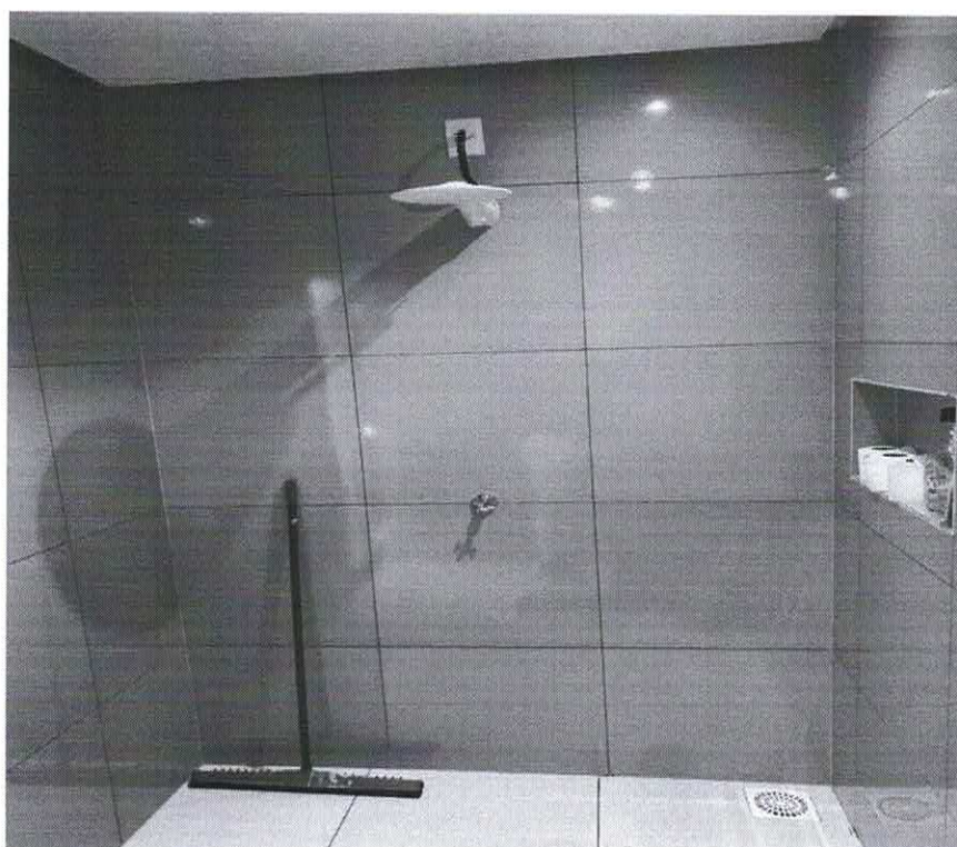
Interior do banheiro.
