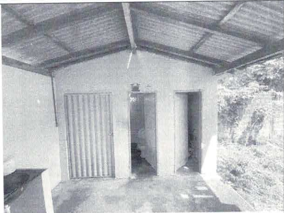
BANHEIROS NA PARTE EXTERNA
