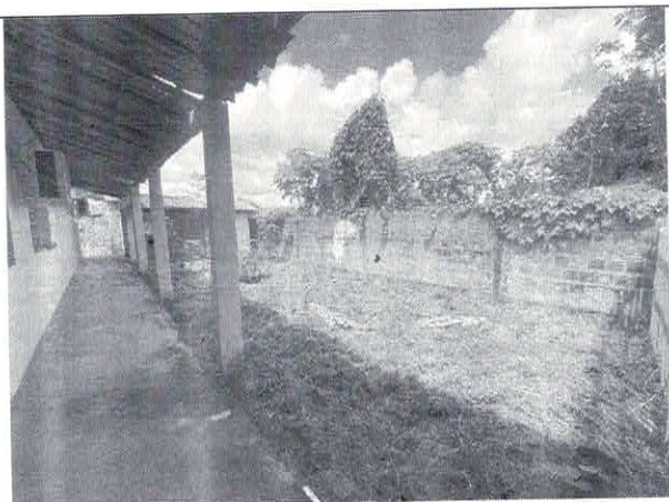
PARTE DE TRÁS DA CONSTRUÇÃO
