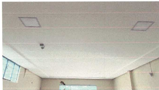
Forro do Prédio
